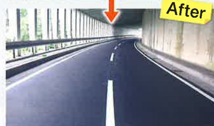
傷んだ舗装をリフレッシュ！
