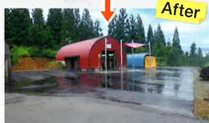
舗装により施設がきれいに！
